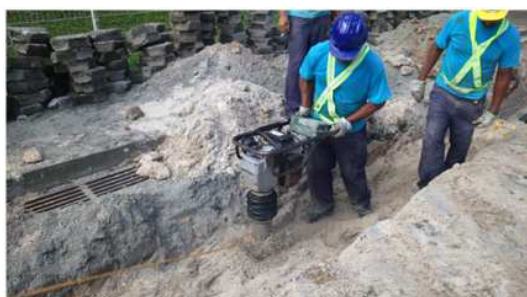
COMPACTAÇÃO DAS CAMADAS DE RECOBRIMENTO DO BANCO DE DUTOS DIRETAMENTE ENTERRADO
