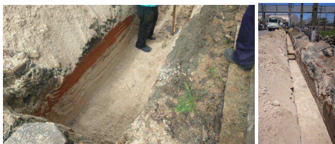
PREPARO DA BASE DE ASSENTAMENTO DOS DUTOS
