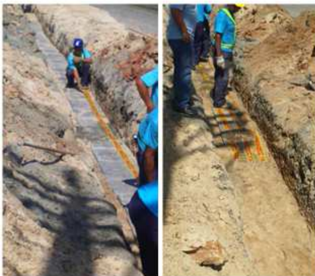
INSTALAÇÃO DA FITA DE AVISO
