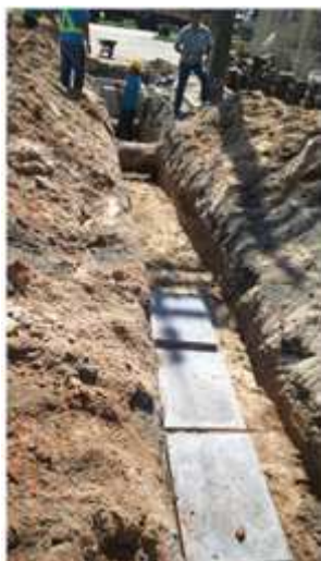
DISTRIBUIÇÃO DE ESFORÇOS NAS PAREDES LATAREAIS E/OU INTERMEDIÁRIAS COM UTILIZAÇÃO DE PLACAS RÍGIDAS
