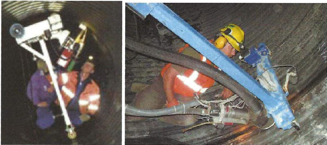
*Figura 30- Soldadura por máquina de soldar interna*
