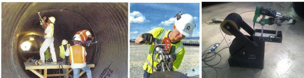
*Figura 29 - Soldadura manual por extrusión*
