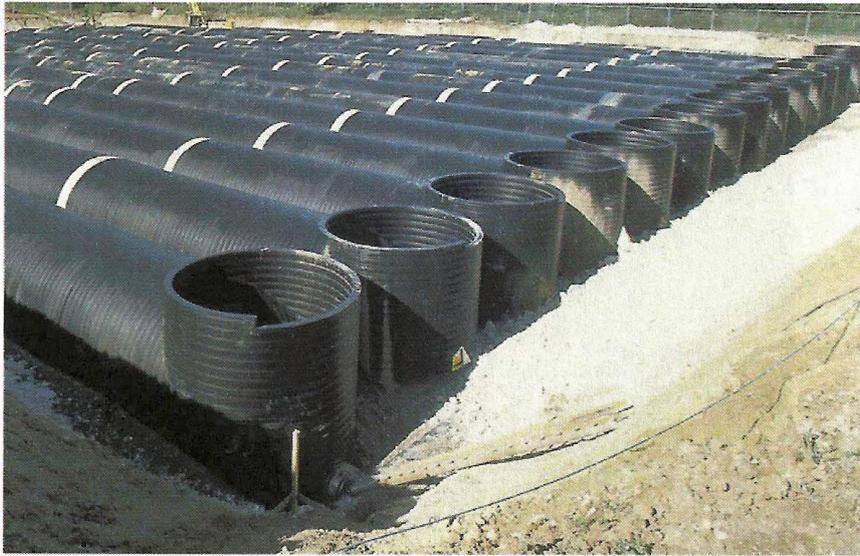
*Figura 45 - Tanque de acumulación o retardo construido con tubos KANAWEHOLITE*
