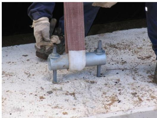
**Figura 24 - Fijar y soportar la base de la tubería en el fondo de la zanja, con bloques/zapatos y correas de anclaje.**
