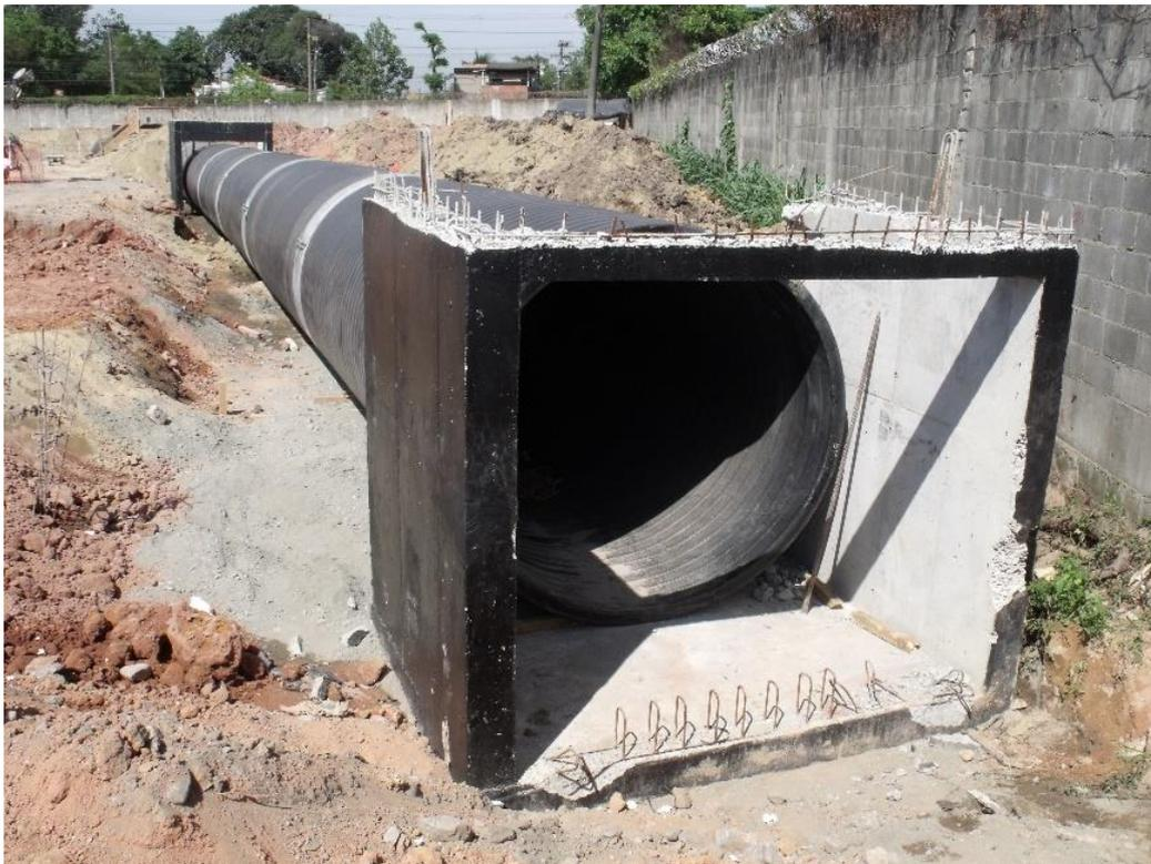
*Figura 28 – Llegada y salida en passage box o PV*
