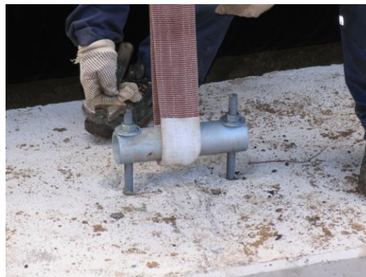
Figura 24 - Fixando e apoiando a base do tubo no fundo da vala, com blocos/sapatas e cintas de ancoragem.
