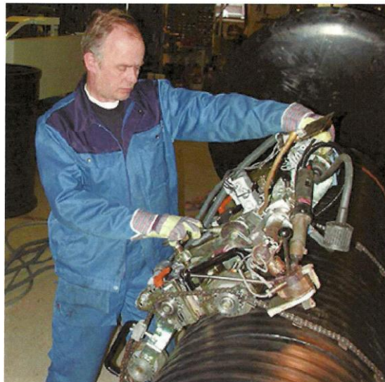
Figura 31 - Solda por máquina de solda externa
