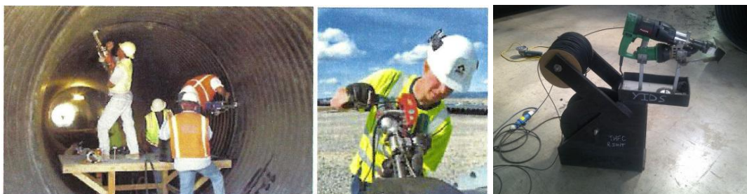
Figura 29 - Solda por extrusão manual
