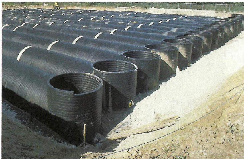
Figura 45 - Tanque de acumulação ou de retardo construído com tubos KANAWEHOLITE
