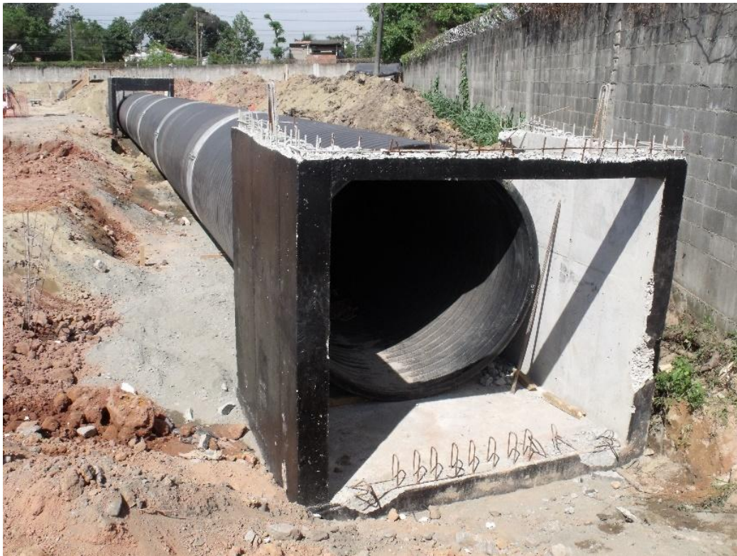
Figura 28 – Chegada/saída em Caixa de Passagem ou PV
