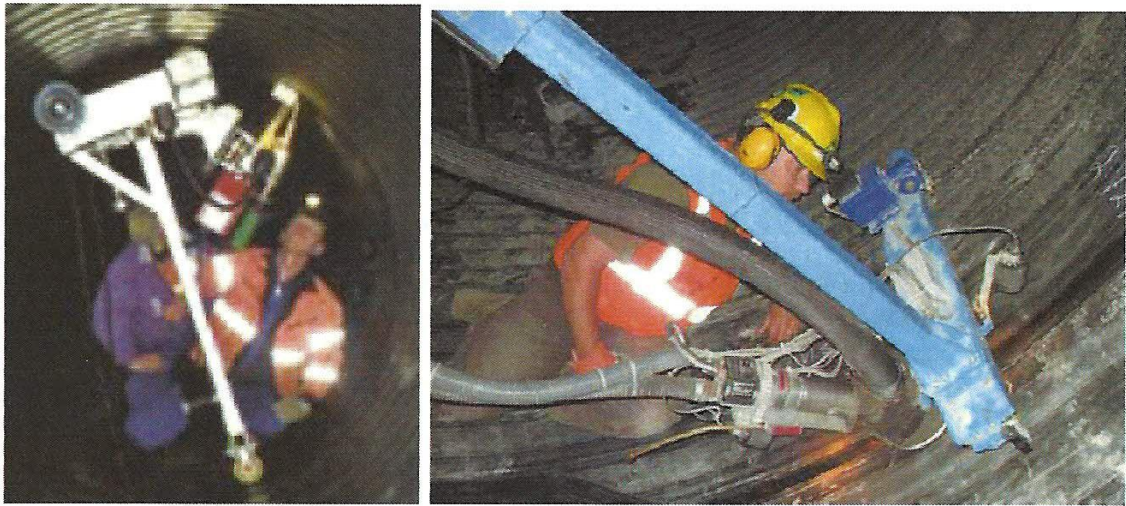
Figura 30- Solda por máquina de solda interna
